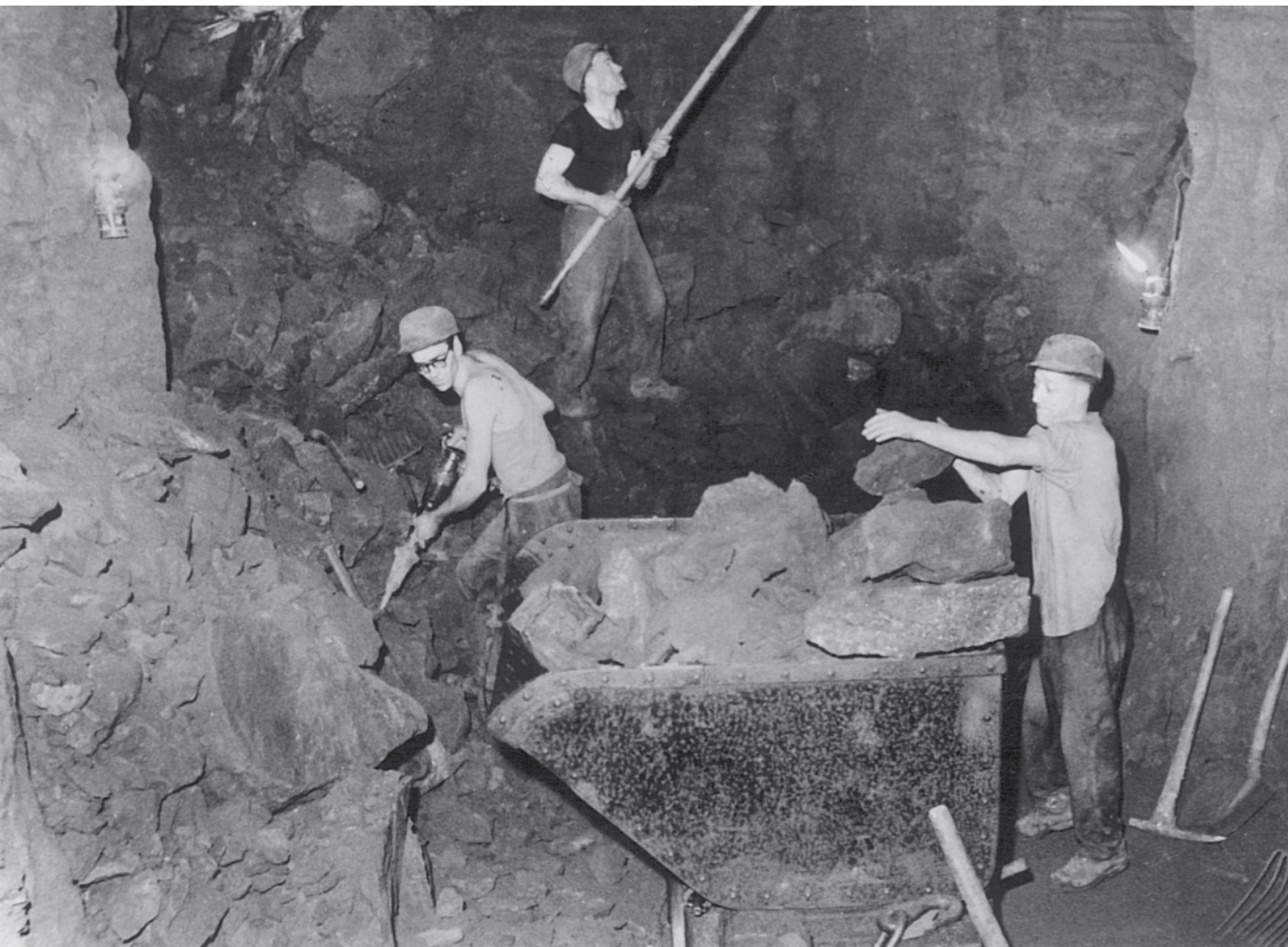
Purgeage du toit, cassage de bloc au marteau-piqueur, chargement du buggy à la main
